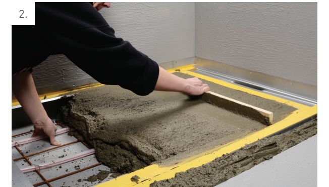
2. Avjämningsmassan eller betongen läggs på i duschplatsen. Avloppsarmaturens inbyggda fall tillsammans med en rätbräda underlättar fallbyggnaden. Därefter kan resten av golvet gutas upp i nivå med avloppsarmaturens horisontella tätskiktsfläns. Ytor för tätskikt skyddas med lämplig bygg / skyddstape.
