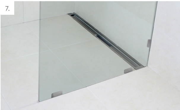
7. Montera slutligen den valda duschväggen.
