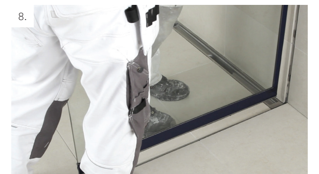
8. Unidrain GlassLine monteras i profilen på vägg och i spåret på ShowerLine armaturen.
