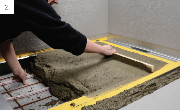
2. Avjämningsmassan eller betongen läggs på i duschplatsen. Avloppsarmaturens inbyggda fall tillsammans med en rätbräda underlättar fallbyggnaden. Därefter kan resten av golvet gutas upp i nivå med avloppsarmaturens horisontella tätskiktsfläns. Ytor för tätskikt skyddas med lämplig bygg / skyddstape.
