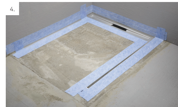
4. Tätskiktet monteras enl tätskiktsleverantörens anvisningar. OBS! Ett systemgodkänt tätskikt av folie eller vätskebaserad typ ska monteras enl gällande branschregler.
