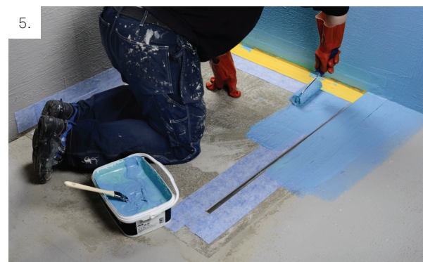
5. Tätskikt monteras på hela golvet och väggarna enligt tillverkarens anvisningar.
